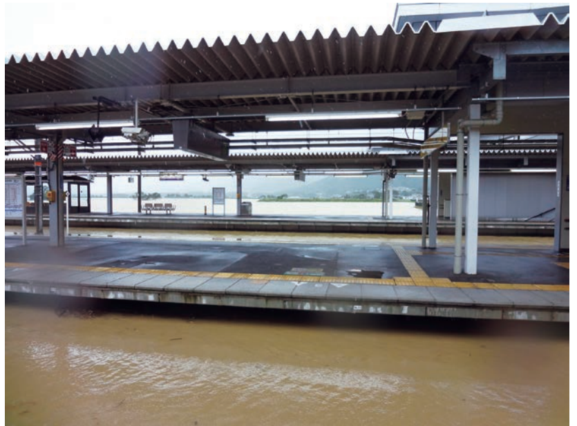
2013年9月 豪雨によるJR山陰本線亀岡駅の浸水
