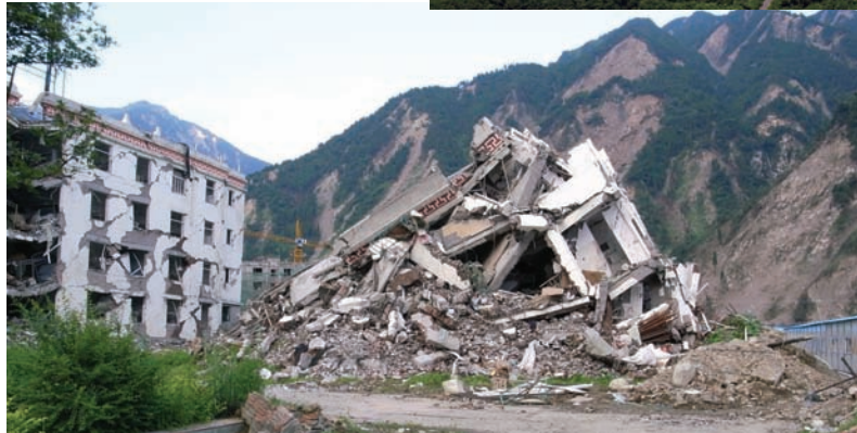
2008年5月 四川大地震 地震・地すべり災害
