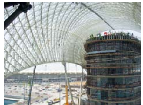
ヤスマリーナホテルの建設現場
